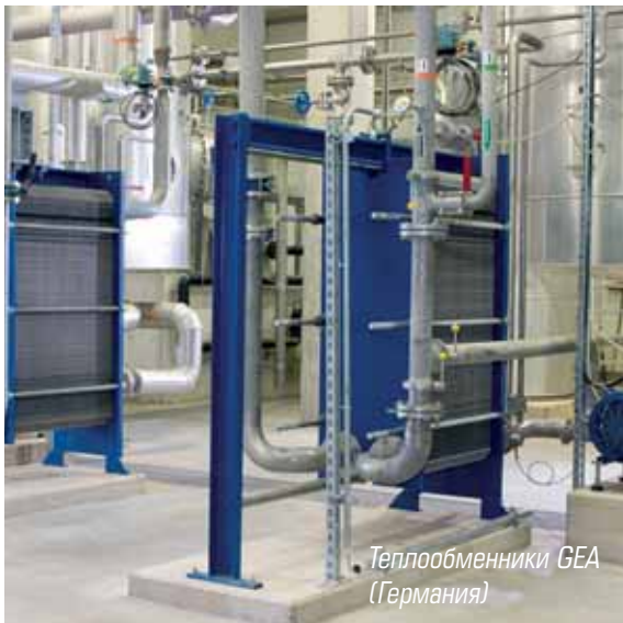
Теплообменники МАШИМПЭКС в котельной ТЦ «Кунцево»
